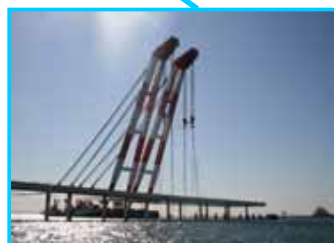
ジャケット据付の状況
