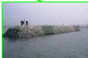
護岸工事の状況
