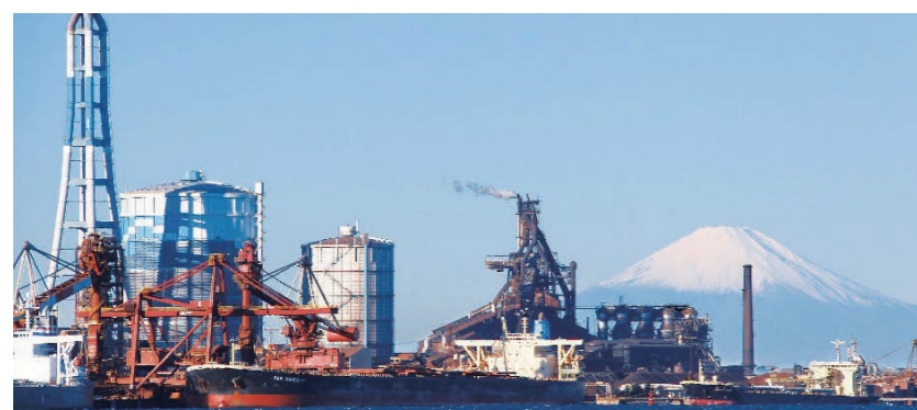
日本製鉄(株)東日本製鉄所 君津地区
