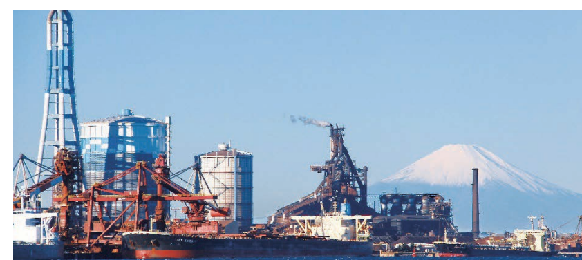
日本製鉄(株)東日本製鉄所 君津地区
