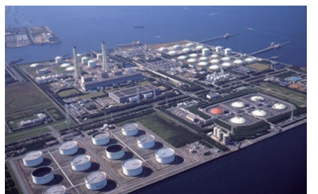
火力発電所 Thermal Power Station
