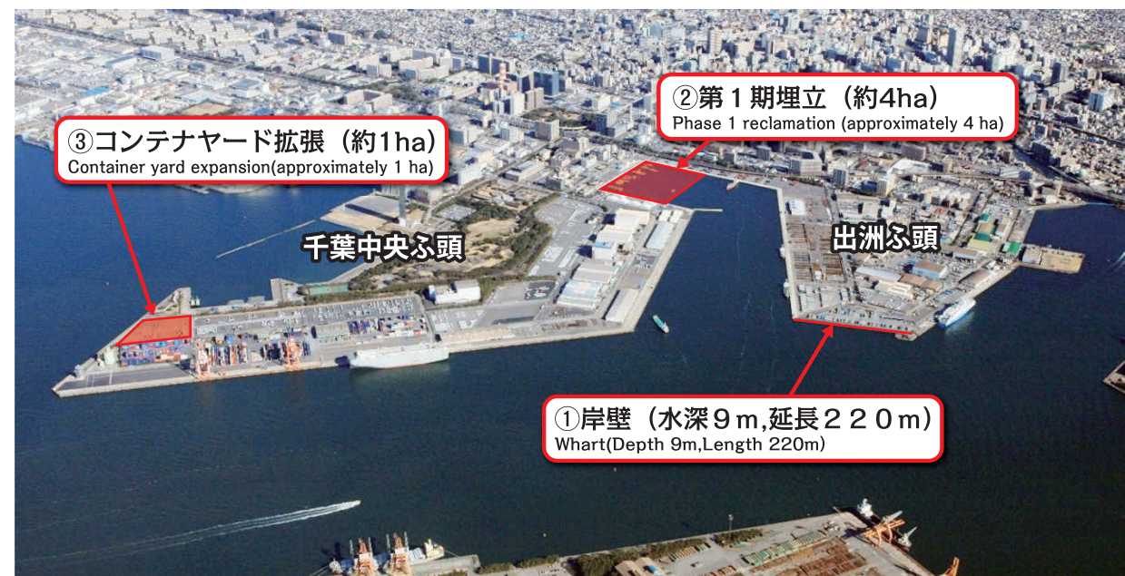
千葉港千葉中央地区 Chiba Port, Chiba Central Area
