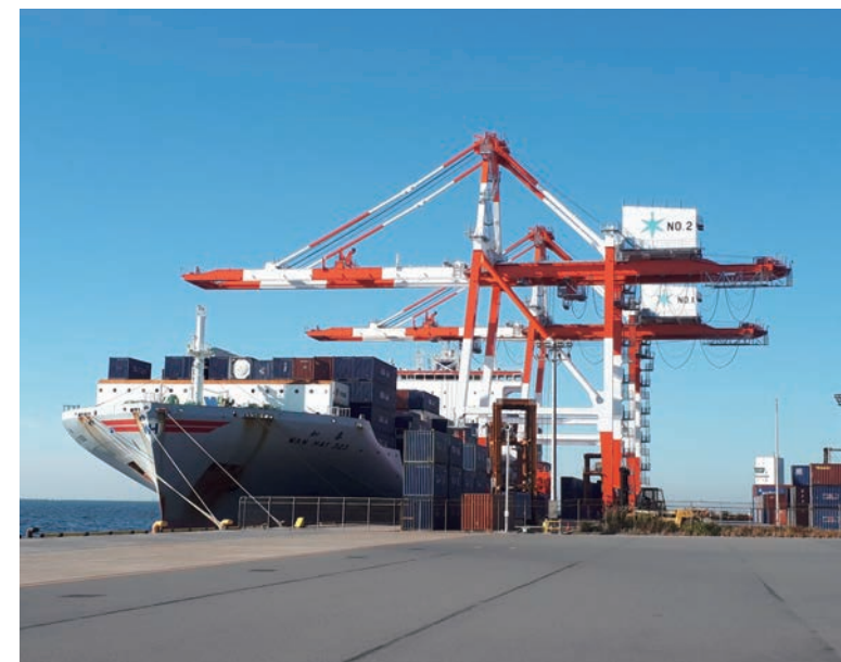
ガントリークレーン Gantry Crane
