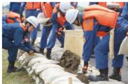
浸水被害拡大を防ぐ土のう積み
