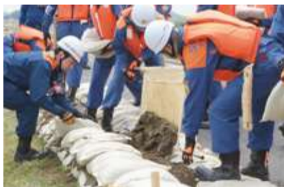
浸水被害拡大を防ぐ土のう積み
