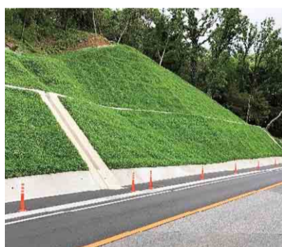
道路のり面(道路脇の斜面)を補強
