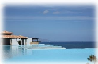
海辺の温浴施設
