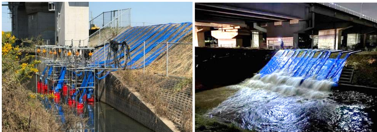
写真（左）仮設ポンプの設置状況（吸水側） 写真（右）仮設ポンプの設置状況（排水側）
