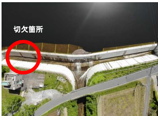
写真9：切欠工事箇所
