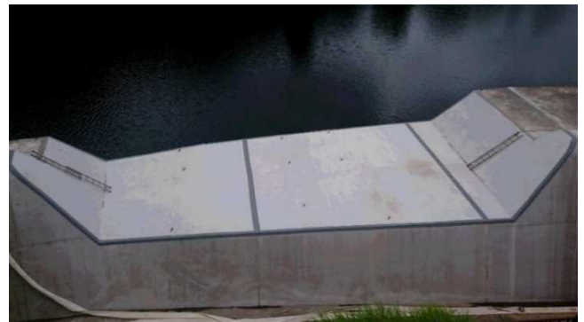
写真10：切欠工事实施後
