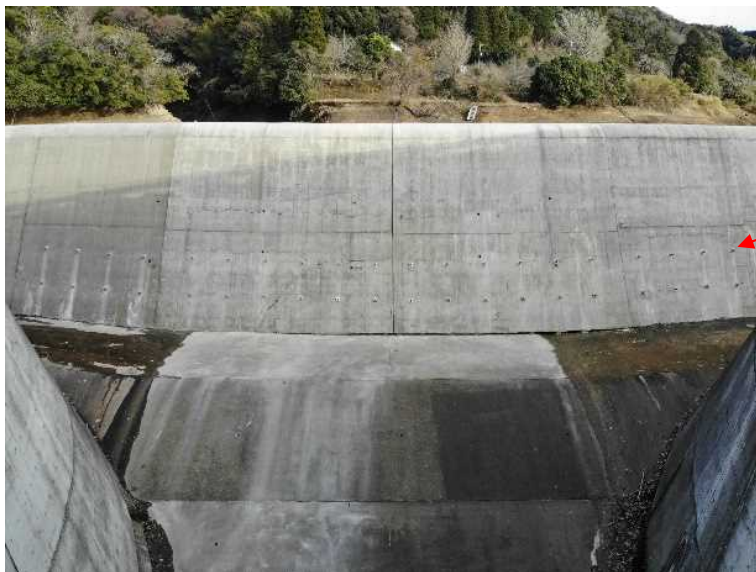
写真 12：中央部 鉄筋挿入工実施後
