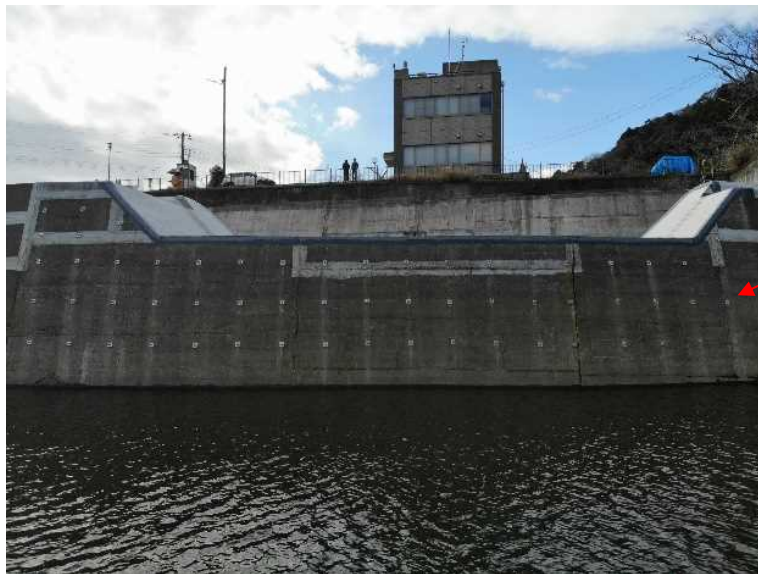
写真 11：切欠部 鉄筋挿入工実施後
