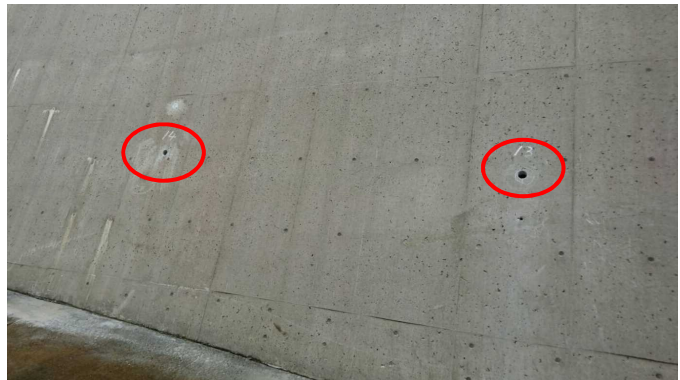
写真8：排水用の孔の設置
