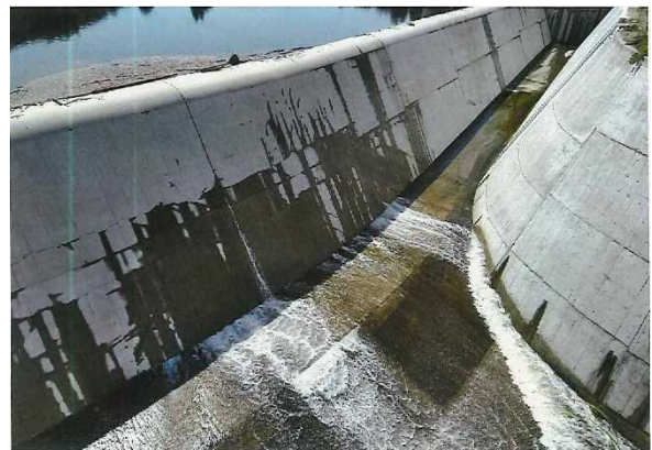
写真2:漏水状況②
