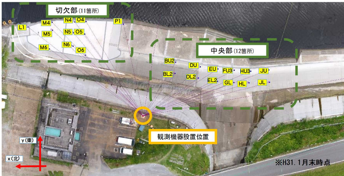
図 4-4：中央部及び切欠部における観測状況
