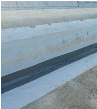
写真7：開口部の防水加工
