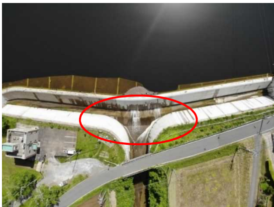
写真1:漏水状況①
