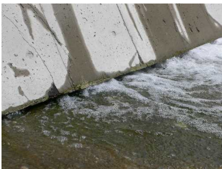
写真3:側壁と水路底盤に隙間
