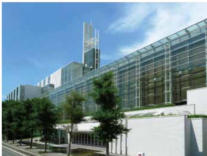
對生產產業集聚的東葛飾地區的中小企業與風險企業提供支撐的「東葛技術廣場大樓」（柏市）
