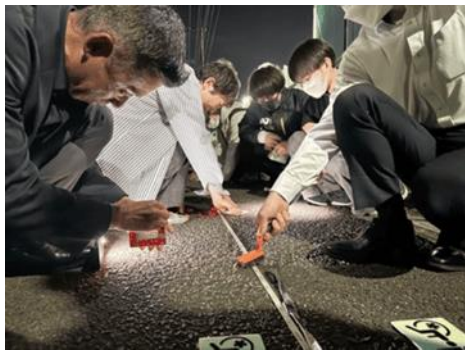
蓄光パネルの設置
