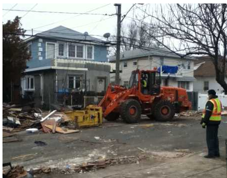
瓦礫撤去の様子
