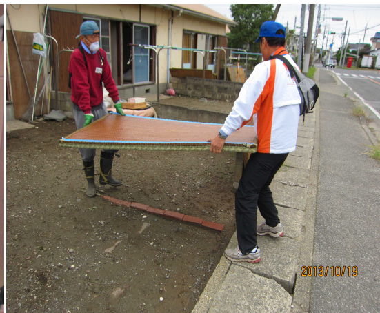
床上浸水で濡れた畳を外へ運びだす
