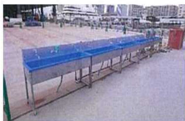
現場の手洗い場所の増設
