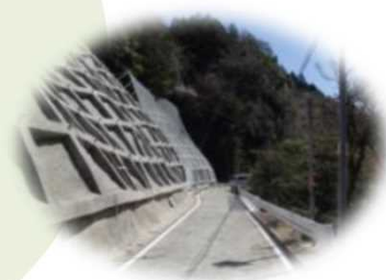
道路法面对策 (主要地方道 市原天津小湊線)
