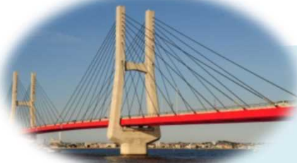
橋架け替え(銚子大橋)
