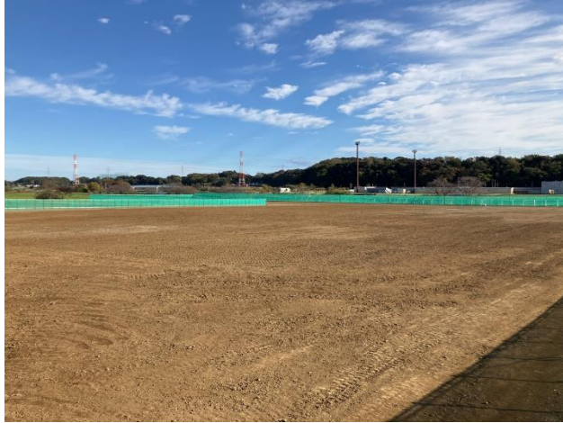
造成概ね完了状況
