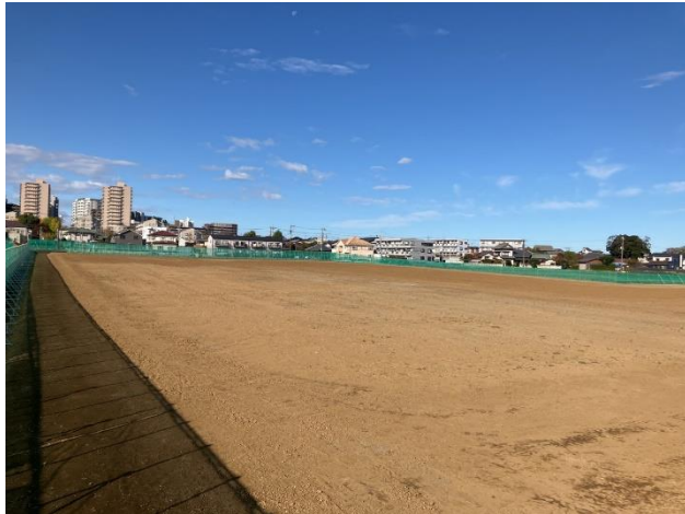
造成概ね完了状況
