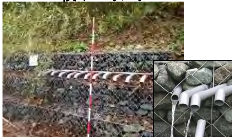
横ボーリング工
