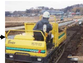
築堤工 (土砂再利用)
