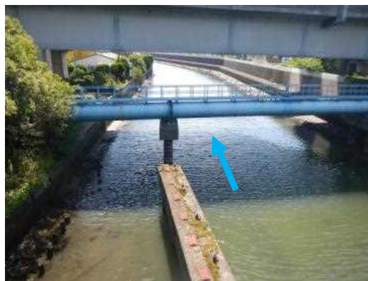
二俣水路 下流を望む
