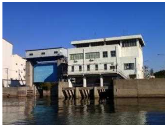
栄排水機場・水門 外観
