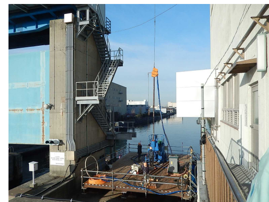
栄水門地盤改良 施工状況
