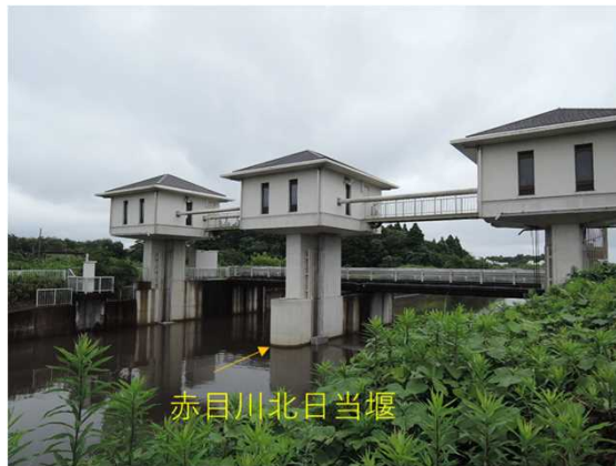
従来のコンクリート構造の取水堰
