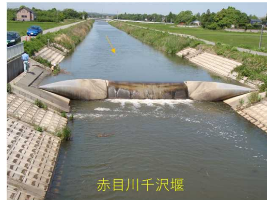
ゴム堰構造の取水堰
