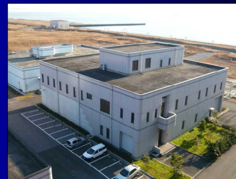
再生水処理棟
