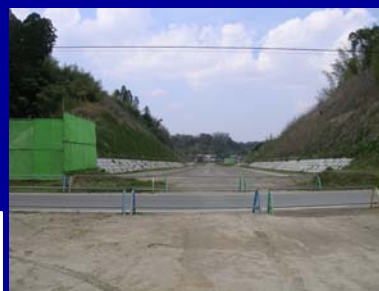
起点側から 茂原市方面を望む
