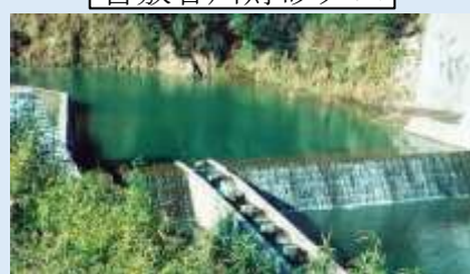
古敷谷川貯砂ダム
