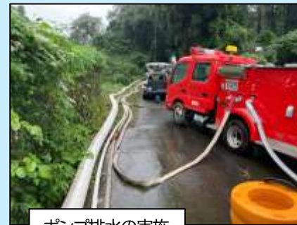
ポンプ排水の実施
