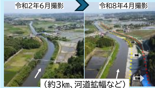
一宮川 河川整備
