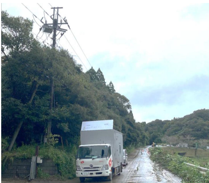
＜高圧発電機車配備の様子＞
