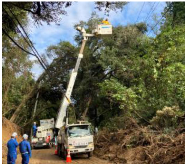
<配電設備改修工事>
