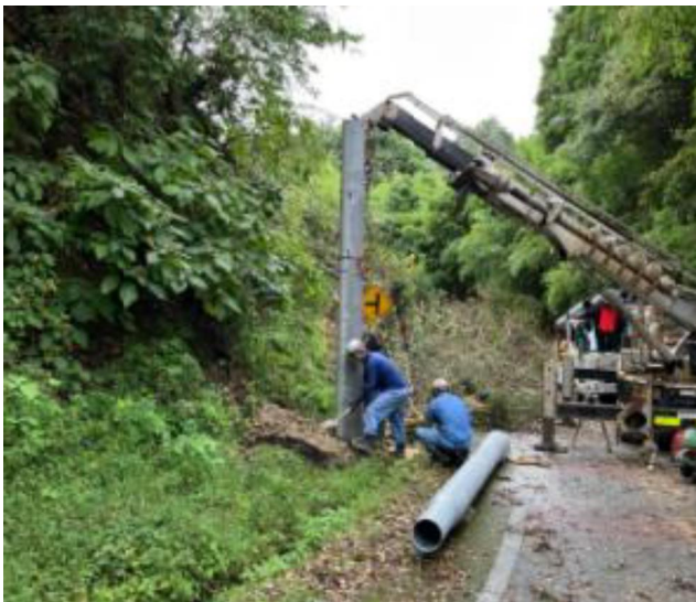
<電柱折損改修工事>
