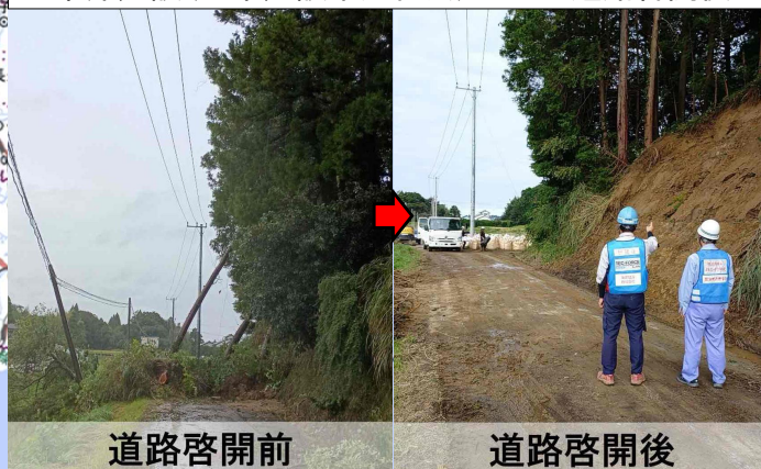
東洋建設(日本建設業連合会)による道路啓開後
