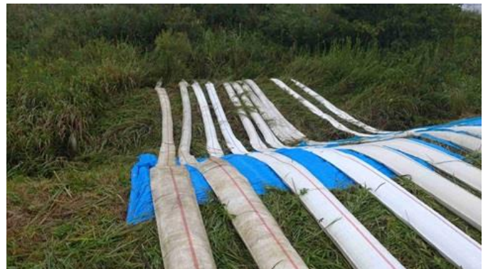
大竹機場におけるポンプ車排水(3)_排水状況 (30日1時25分稼働開始)
