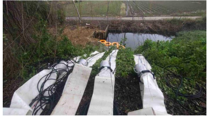
排水ポンプ車の配備(2)
