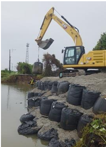
北印旛沼長門川における堤防の応急復旧状況
