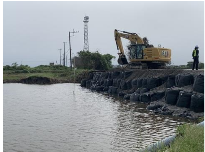
北印旛沼長門川における堤防の応急復旧状況(2)
