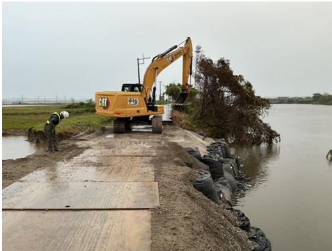
北印旛沼長門川における堤防の応急復旧状況(1)
