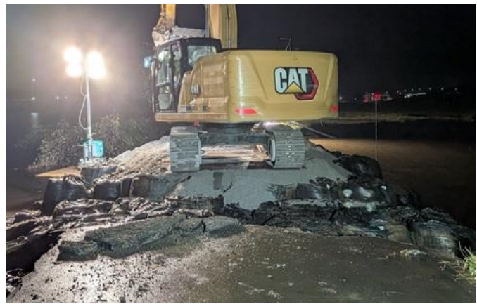
北印旛沼長門川における堤防の応急復旧状況(4)
