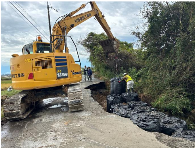
北印旛沼長門川における管理用通路の復旧(1)
