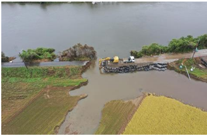
北印旛沼長門川における堤防の応急復旧状況(3)
