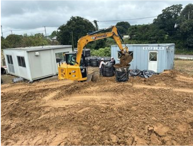
長門川における大型土のうの製作状況
