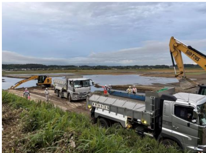
北印旛沼船形干拓の応急復旧作業状況 (決壊口への石の投入)
