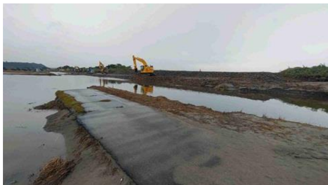
北印旛沼船形干拓における堤防の 荒締切施工状況(1)
