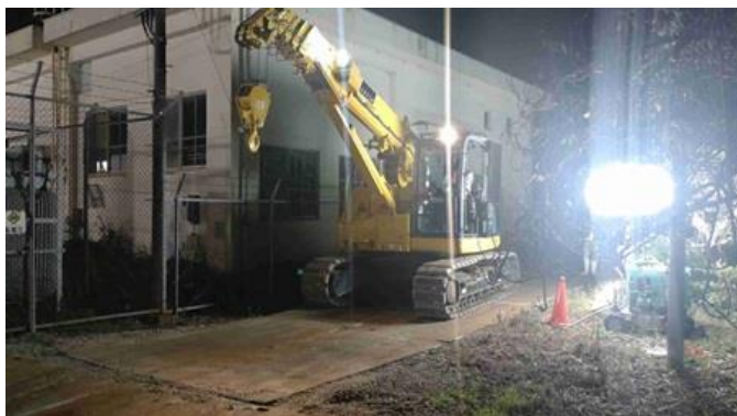
北印旛沼_船形干拓における工事用道路の整備状況
