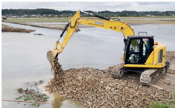
北印旛沼船形干拓の応急復旧作業状況 (石材投入)(2)
