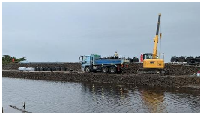
北印旛沼船形干拓における堤防の 荒締切施工状況(2)
