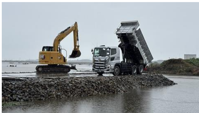
北印旛沼船形干拓における堤防の応急復旧(近景) 北印旛沼船形干拓における堤防の応急復旧(遠景)
