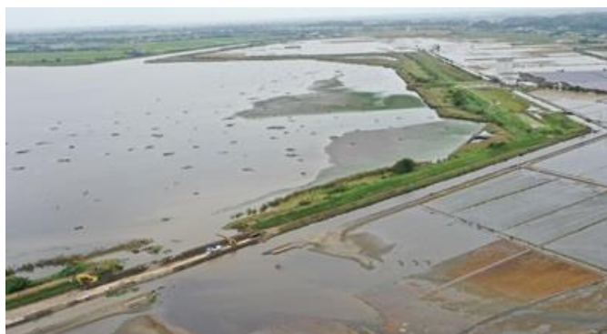
北印旛沼船形干拓における堤防の 荒締切施工状況(遠景)
