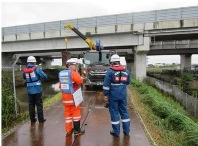
北印旛沼船形干拓の応急復旧作業状況 (工事用道路)
