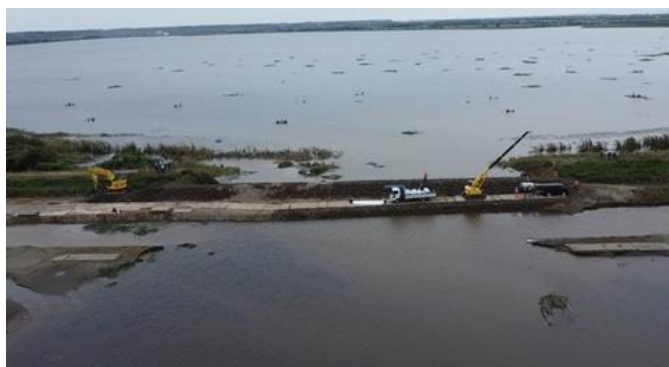
北印旛沼船形干拓における堤防の 荒締切施工状況(3)
