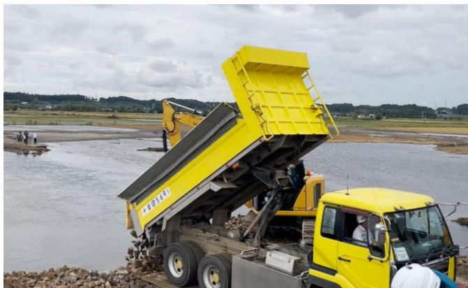
北印旛沼船形干拓の応急復旧作業状況 (石材投入)(1)
