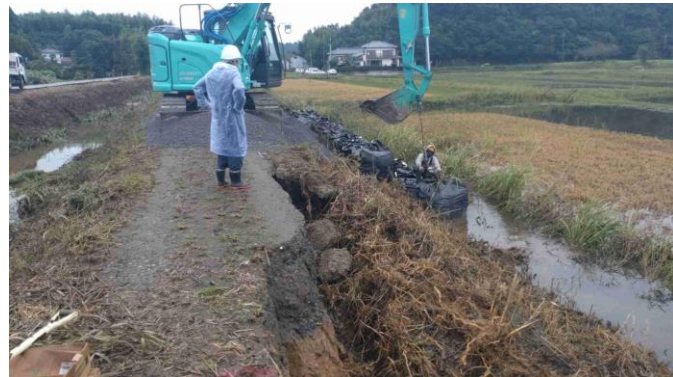
北印旛沼角川における大型土のう据付状況
