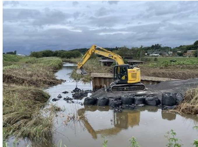
北印旛沼角川における堤防の応急復旧状況(4)
