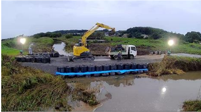
北印旛沼角川における堤防の応急復旧完了
