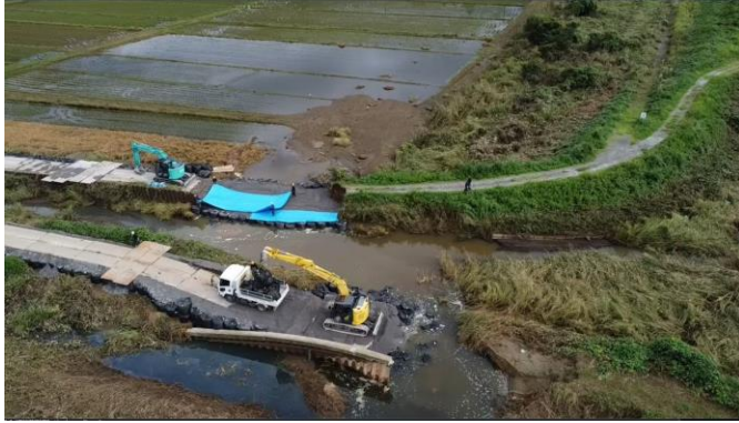
北印旛沼角川における堤防の応急復旧状況(1)
