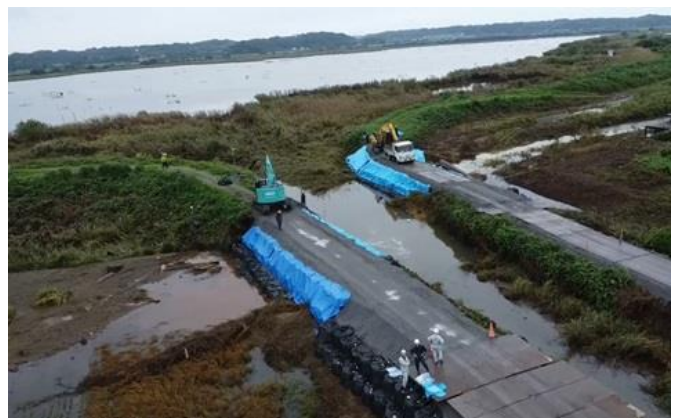
北印旛沼角川における堤防の応急復旧(4)
