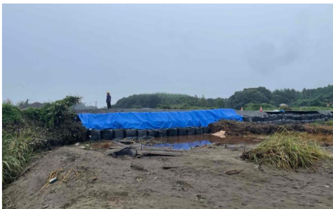
北印旛沼角川における堤防の応急復旧(3)
