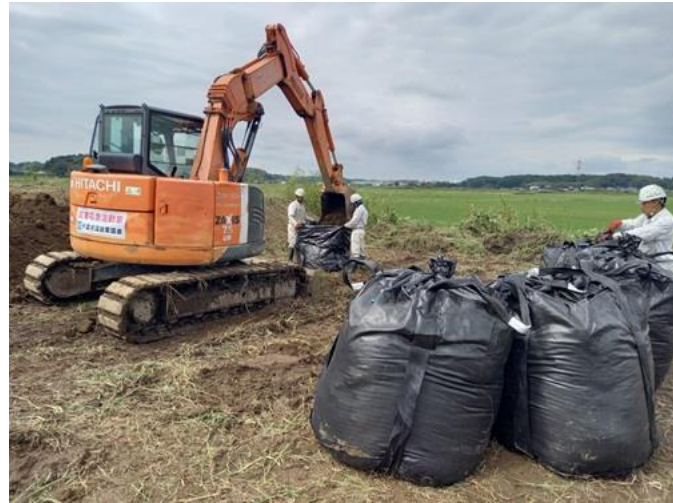
北印旛沼角川における大型土のうの製作状況
