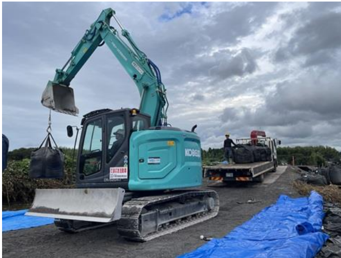
北印旛沼角川における堤防の応急復旧状況(3)
