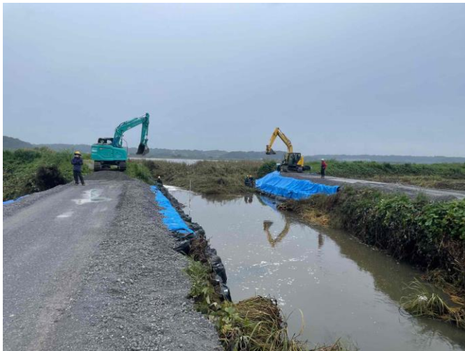
北印旛沼角川における堤防の応急復旧(1)
