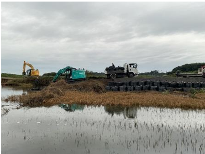
北印旛沼角川における大型土のうの据付状況
