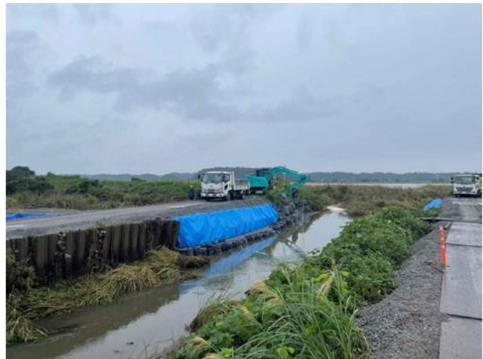
北印旛沼角川における堤防の応急復旧(2)
