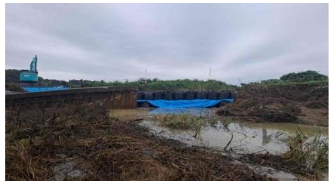
北印旛沼角川における堤防の応急復旧状況(2)
