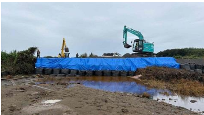
北印旛沼角川における堤防の応急復旧状況(1)
