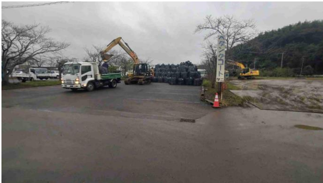
北印旛沼角川における大型土のうの搬入状況
