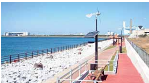
高潮対策事業 千葉港海岸（習志野地区）
