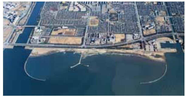
海岸環境整備事業 千葉港海岸（検見川地区）
