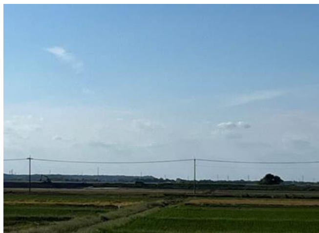
北印旛沼船形干拓における 堤防荒締切の完成状況(遠景)
