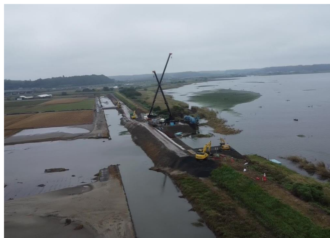
北印旛沼船形干拓における 堤防の鋼矢板二重締切工施工状況(2)
