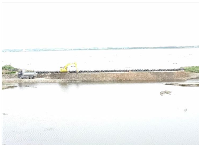
北印旛沼船形干拓における 堤防の荒締切施工状況(1)
