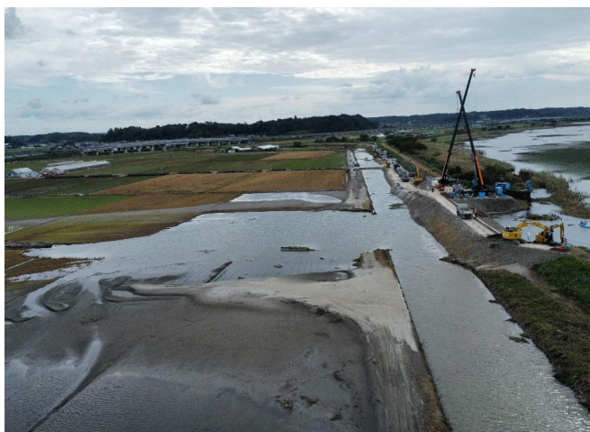
北印旛沼船形干拓における 堤防の鋼矢板二重締切工施工状況(1)
