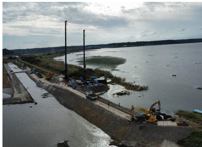
北印旛沼船形干拓における 堤防の鋼矢板二重締切工施工状況(2)
