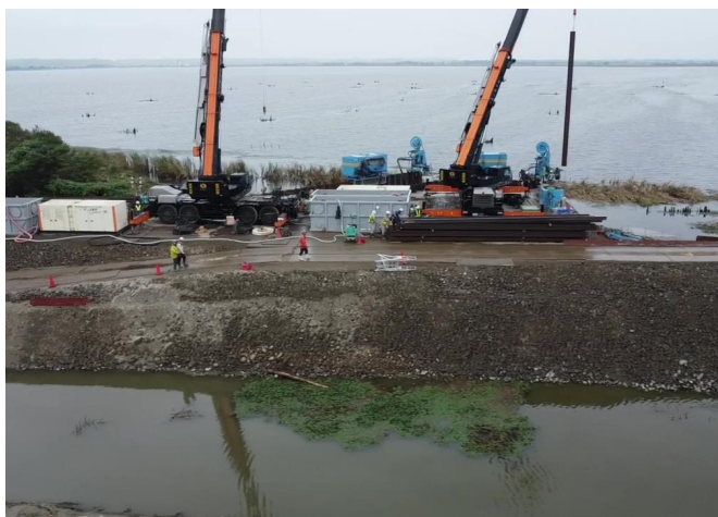
北印旛沼船形干拓における 堤防の鋼矢板二重締切工施工状況(1)
