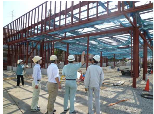
建築パトロールの様子
