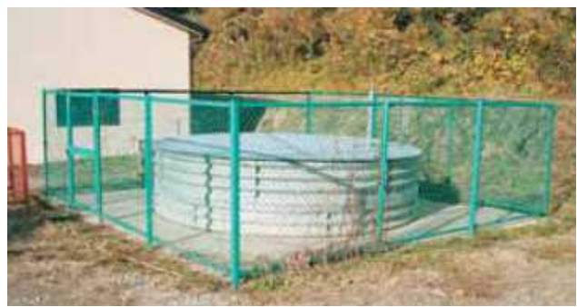
集水井工（南房総市大井）
