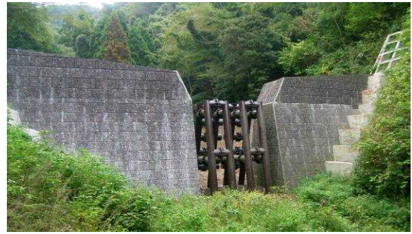
砂防堰堤工（南房総市合戸）
