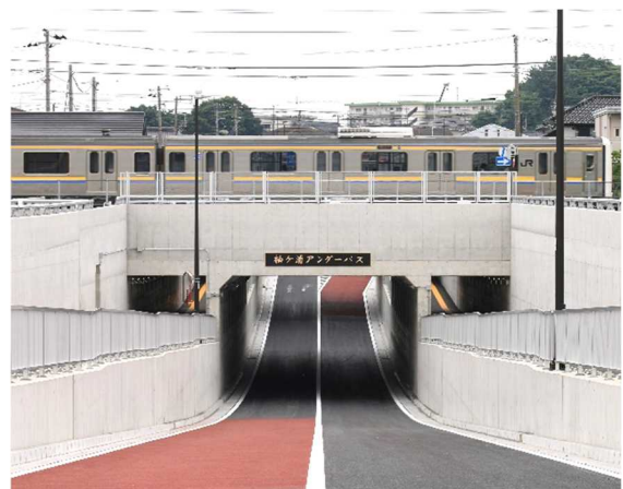
(都) 高須箕和田線 (袖ヶ浦市)
