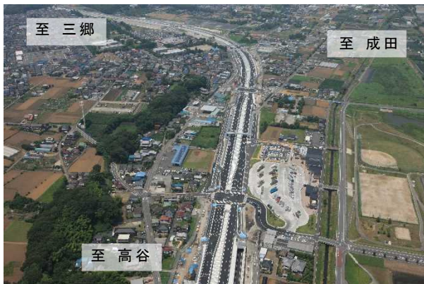
北千葉ジャンクション付近（写真①）
