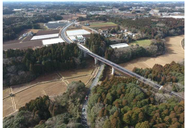
県道成田小見川鹿島港線 沢中白清水橋（多古町～香取市）
