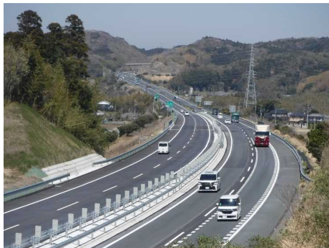
館山自動車道（君津市六手地区） ※平成31年3月 4車線化運用開始
