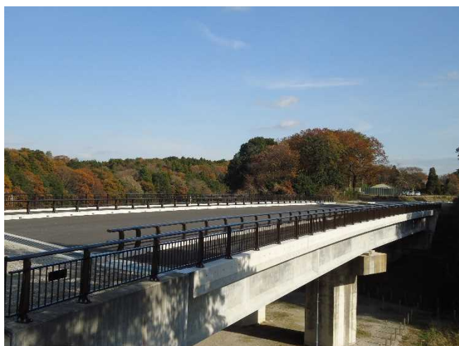
国道 296 号 八千代バイパス（八千代市）
