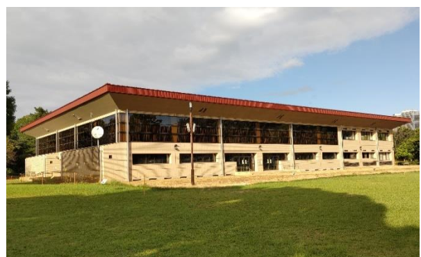
柏の葉公園コミュニティ体育館屋根改修工事
