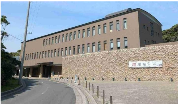
海の博物館本館棟建築改修工事
