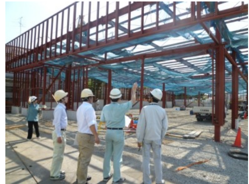
建築パトロールの様子
