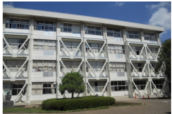
県有施設の耐震改修
