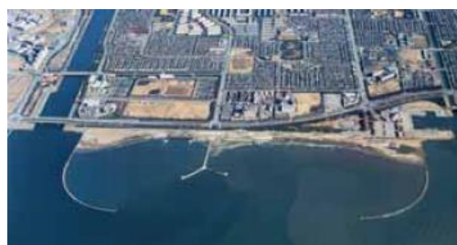
海岸環境整備事業 千葉港海岸（検見川地区）
