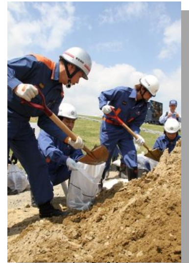
土のうづくり
