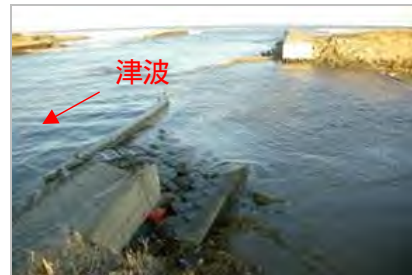
津波による堤防決壊(二)木戸川
