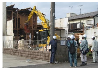
解体工事現場のパトロール
