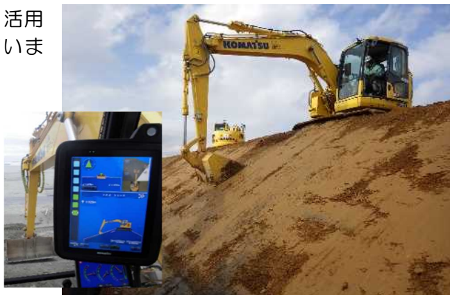
ICT活用工事
