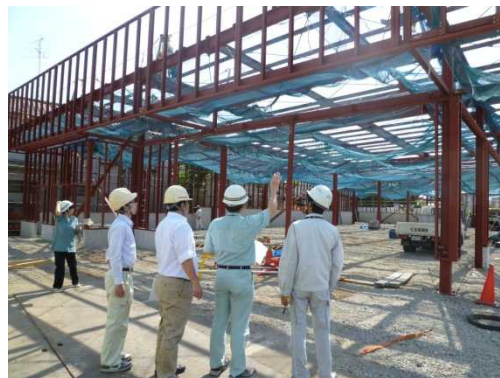
建築パトロールの様子
