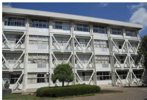
県有施設の耐震改修
