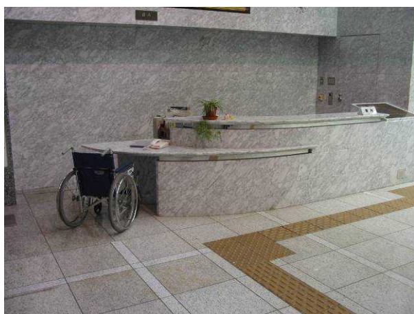
高さの異なるカウンターを設け多様な方に配慮した受付
