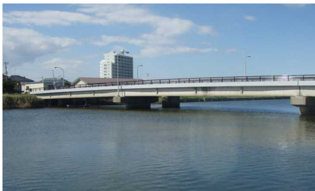
新一宮大橋（長生郡一宮町）
