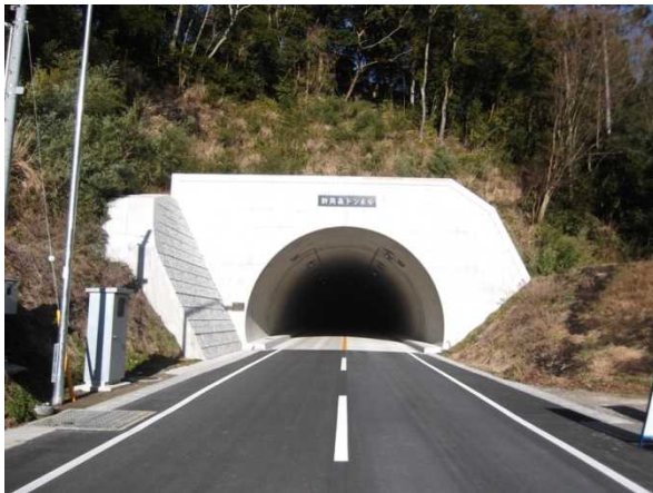
新筒森トンネル（夷隅郡大多喜町）
