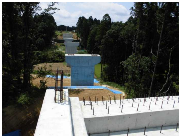
(仮称) 第一沢橋付近 (香取郡多古町)
