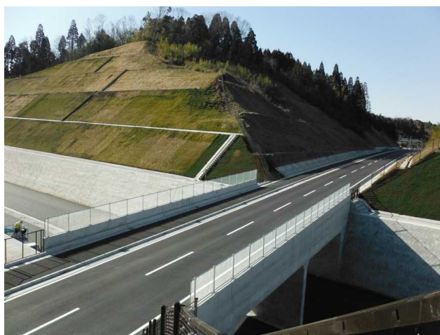
県道五井本納線新治バイパス（茂原市）
