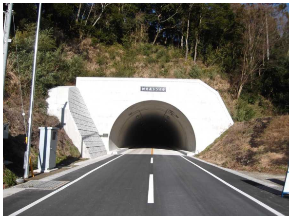
新筒森トンネル（夷隅郡大多喜町）
