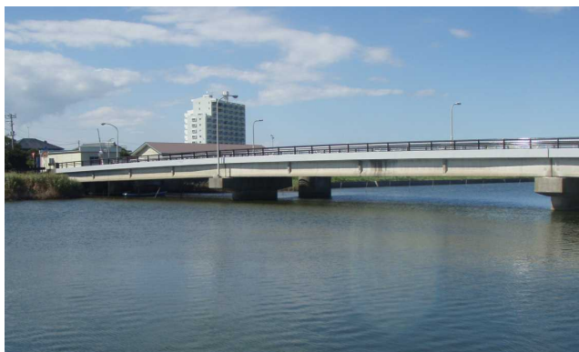
新一宮大橋（長生郡一宮町）
