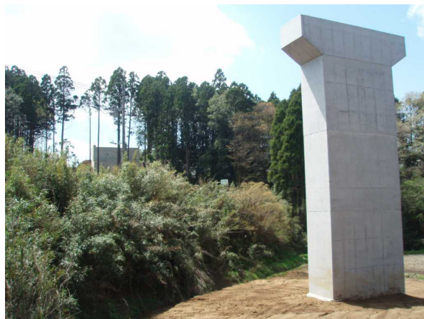
(仮称) 第一沢橋付近 (香取郡多古町)
