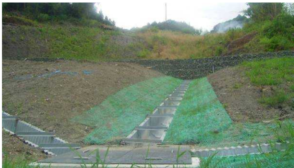
明暗渠工 (南房総市山田)
