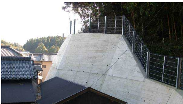
張りコンクリート工 (いすみ市大原)
